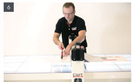
6 Elimine cualquier exceso de revestimiento.
